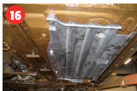
16 Færdighandlet vognbund efter montering af bundskjold.
